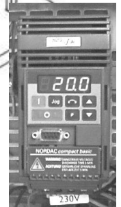
Variateur de fréquence permettant de régler le débit de la vis sans fin d'alimentation
