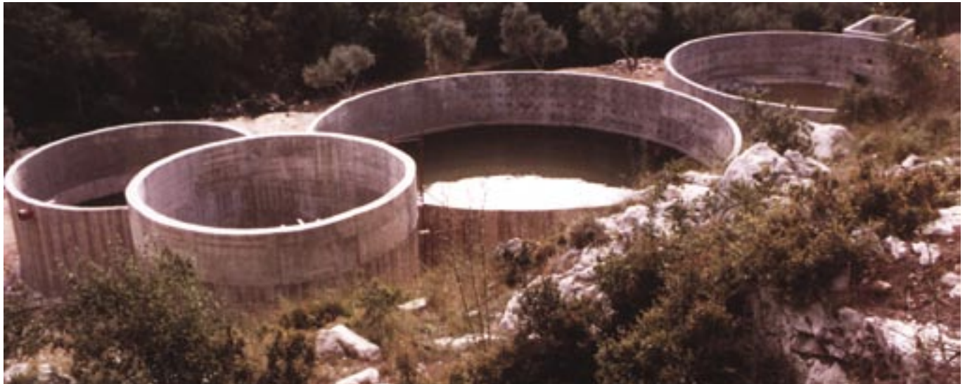
محطة الصرف الصحي وقد تم انجازها
