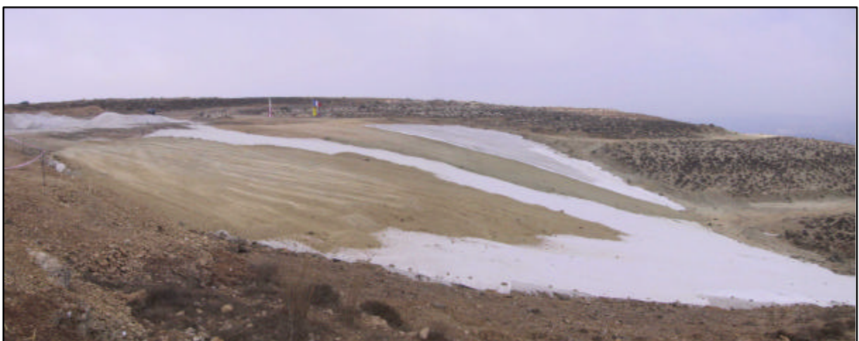
Vue générale de la décharge de Slayeb (22 septembre 2002)
